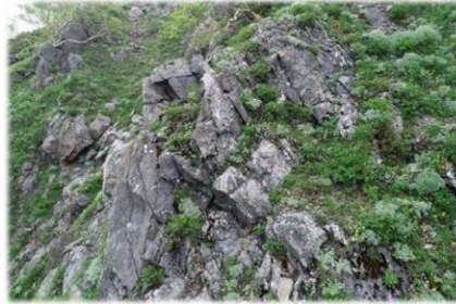
UAV 撮影(岩壁)
